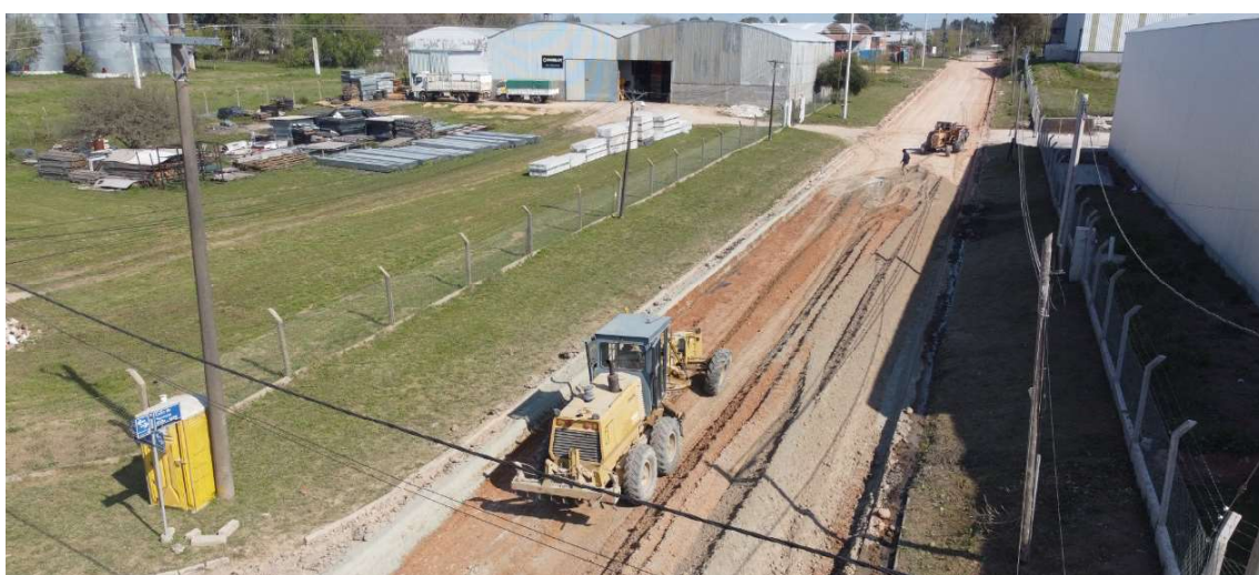
Trabajos para la puesta en valor del Parque Industrial.
