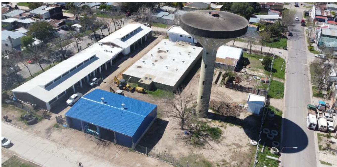
Nuevos tanques en el marco del Plan Maestro de Agua Potable.
