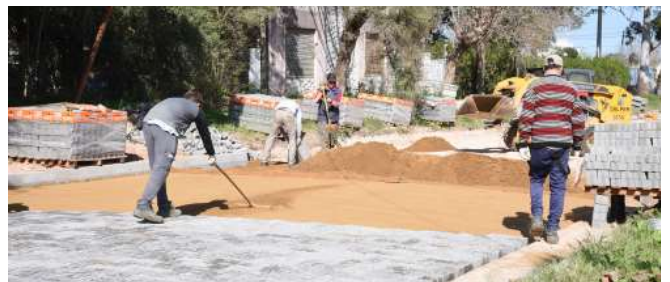
Pavimentación barrio Congreso De Oriente.
