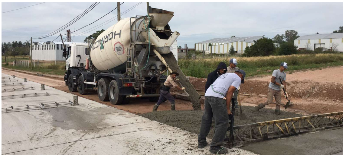
Se pavimentaron las principales calles internas del Parque Industrial.
