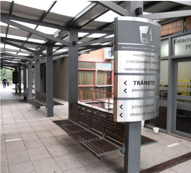
Remodelación de accesos al Municipio.
