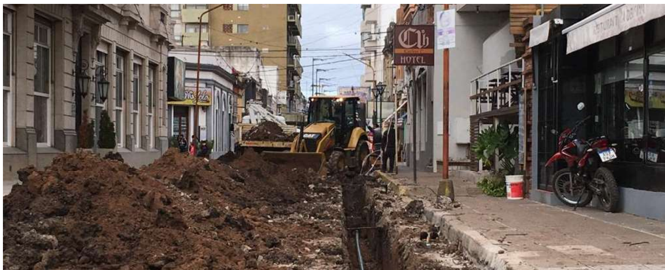
Reemplazo de cañerías en el Casco Céntrico.
